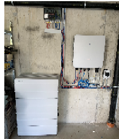
PVA Simone & Franco Parrillo Flachdach und Garage: 13.3 kWp , Speicherbatterie 22.4 kWh
