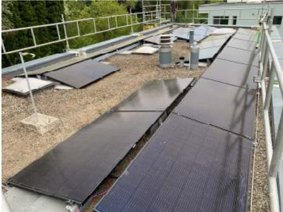
PVA Simone & Franco Parrillo Flachdach und Garage: 13.3 kWp , Speicherbatterie 22.4 kWh
